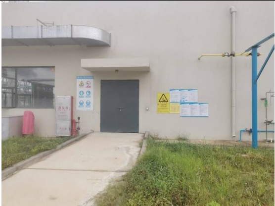
危险废物暂存间
